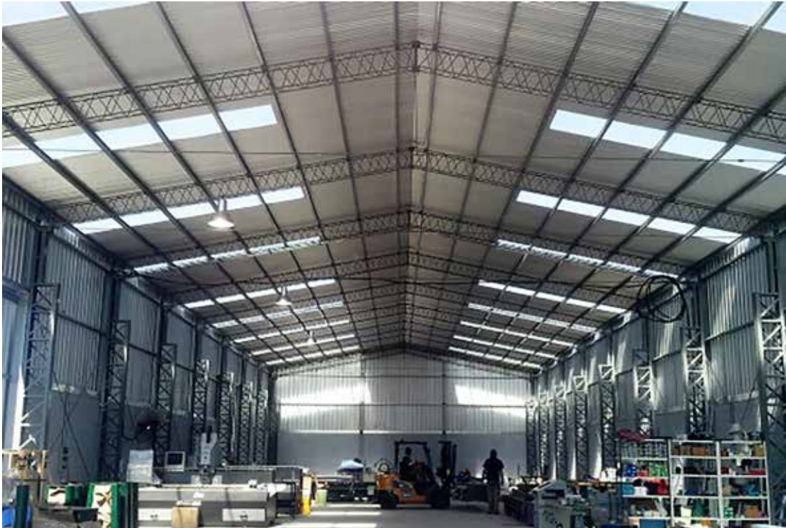
Interior de la nave 3.
